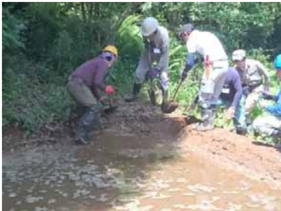
写真 2 2、2 3 : 田んぼの水位調整用配管作り
