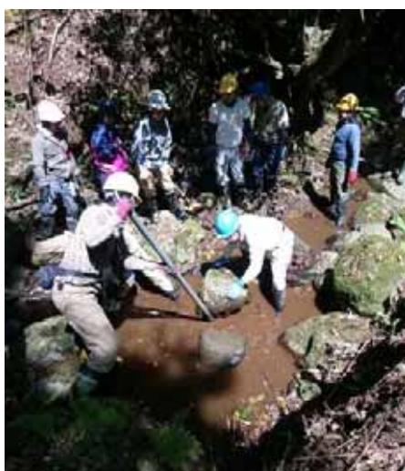
写真 1 2、1 3 : どの面を上にするかが大切であり、かませるように石を組む
