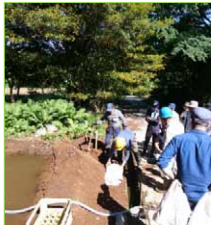
写真6．田んぼの修復作業
