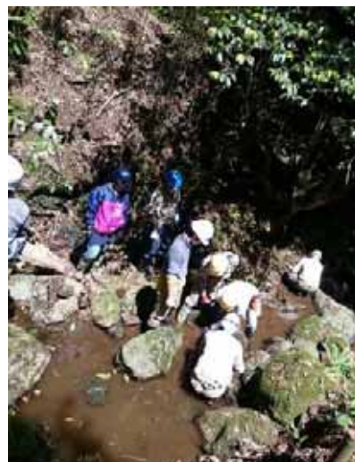
写真 1 2、1 3 : どの面を上にするかが大切であり、かませるように石を組む
