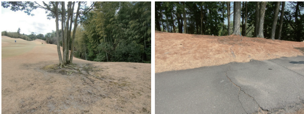
写真 3.1.3 芝生やカート路の根上がり
