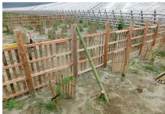
静砂垣の設置
